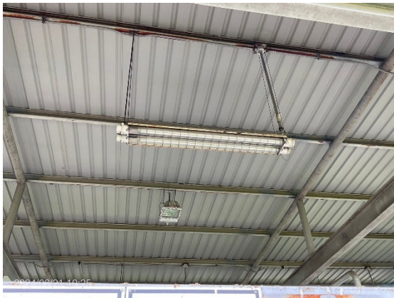
ติดตั้งระบบ Gas Sensor Detector เพื่อตรวจสอบ การรั่วไหลของก๊าซบริเวณสถานีบริการ
