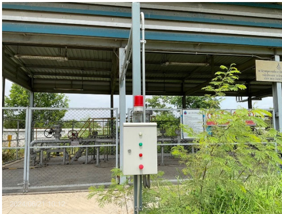
ติดตั้งระบบ Gas Sensor Detector เพื่อตรวจสอบ การรั่วไหลของก๊าซบริเวณสถานีบริการ
