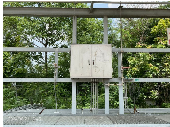
ติดตั้งสายกราวด์บริเวณตู้ควบคุมการจ่ายก๊าซทุกตู้ เพื่อป้องกันอันตรายจากกรณีที่มีกระแสไฟฟ้ารั่ว
