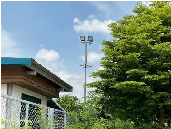
ติดตั้งกล้องวงจรปิด (CCTV) ไว้ที่เสาไฟส่องสว่างที่อยู่รอบสถานีบริการ และบริเวณอาคารสำนักงาน
