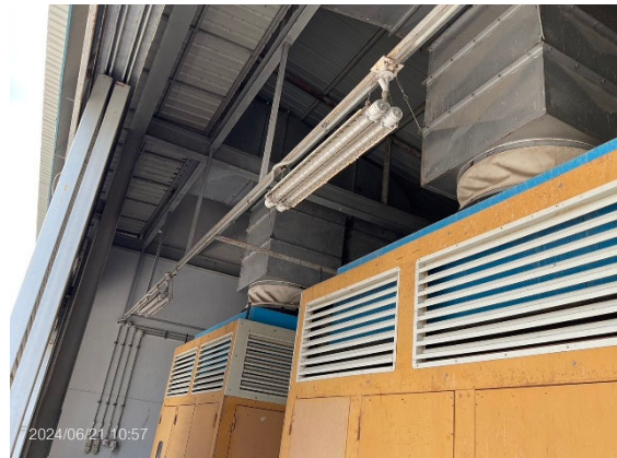
ติดตั้งสายกราวด์บริเวณตู้ควบคุมการจ่ายก๊าซทุกตู้ เพื่อป้องกันอันตรายจากกรณีที่มีกระแสไฟฟ้ารั่ว
